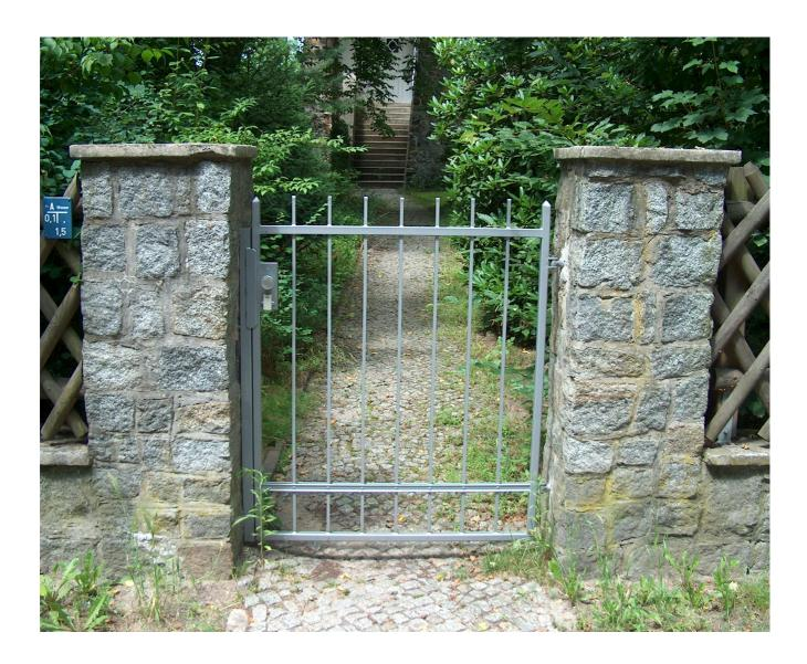
**Eingangstür**: Breite 1000mm, H=1500mm Rahmen aus QR 30x30mm, unten durchlaufende Hespeneisen mit Füllstäben 14x14mm
